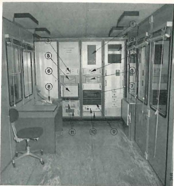
Fig. 1. — Vista d'insieme delle apparecchiature poste all'interno del contenitore: (1) trasmettitore; (2) condizionatore; (3) gruppo FI del sistema di inseguimento; (4) gruppo FI del sistema di telemetria; (5) registratori a carta; (6) tracciatore XY; (7) calcolatore; (8) telescrivente; (9) convertitore numerico-analogico; (10) alimentatori calcolatore; (11) alimentatori gruppi RF.
